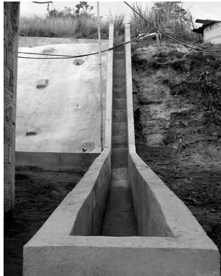
Figura 13 - Solo grampeado com drenagem superficial de descida de água em escada. Piraí, RJ
