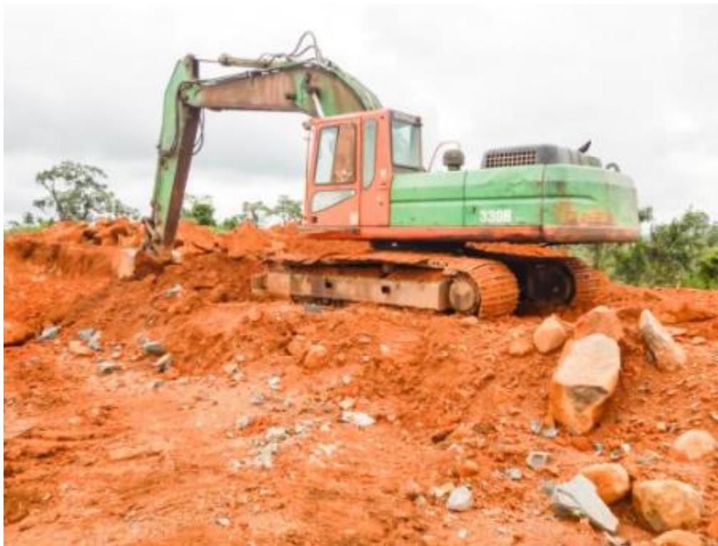
Figura 2- Processo de extração da argila
