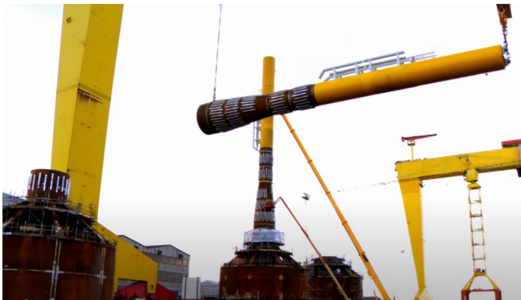
Figura 4 – Exemplo de etapa de montagem da estrutura.
