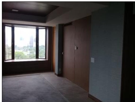
Figura 1 - Pavimento do Tipo Escritório
